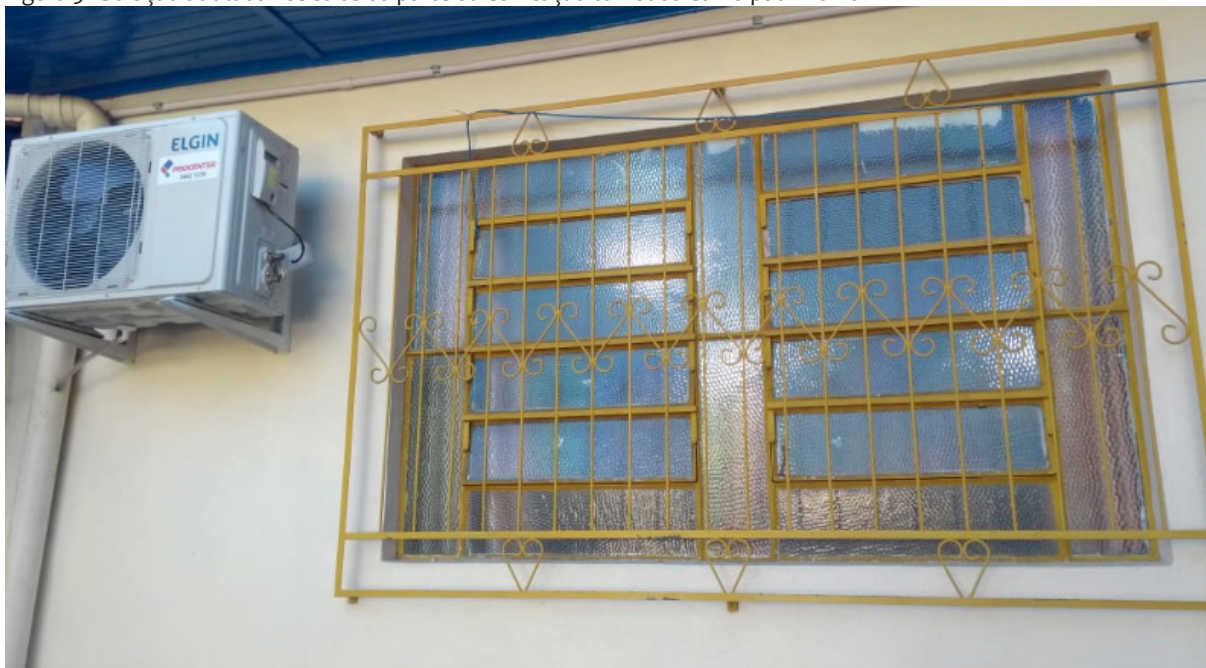
Figura 5 - Solução adotada nas salas da parte da edificação tombada como patrimônio.
