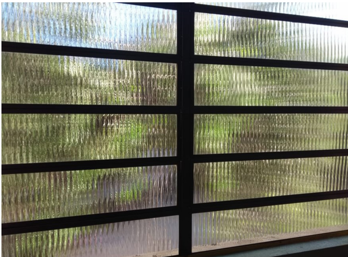
Figura 4 - Janela substituída na sala 11. Foi utilizado vidro trabalhado a fim de reduzir o uso de cortinas, aumentando o conforto luminoso.
