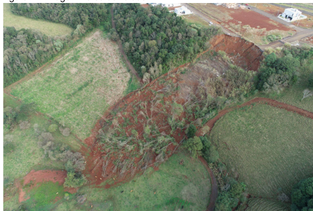
Figura 2 – Imagem Aérea do Talude
