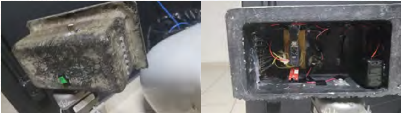
Figura 6 - Estrutura: Modulo de Processamento
