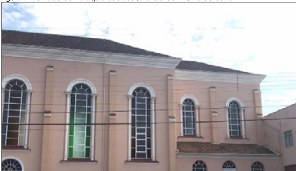
Figura 1 - Telhado da Paróquia São João Batista com telha de barro
