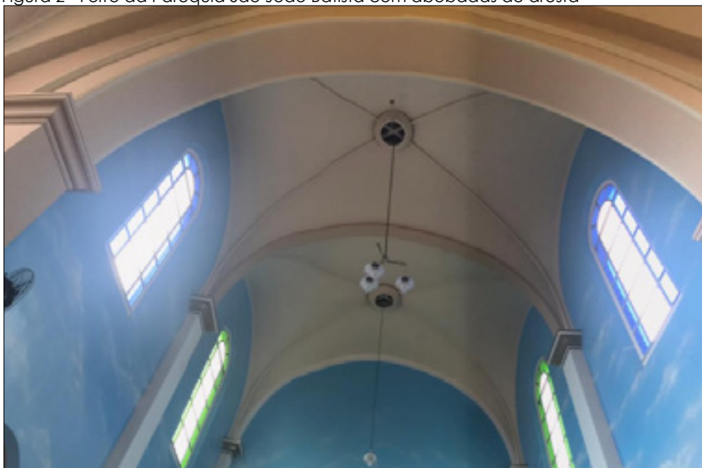
Figura 2 - Forro da Paróquia São João Batista com abóbadas de aresta
