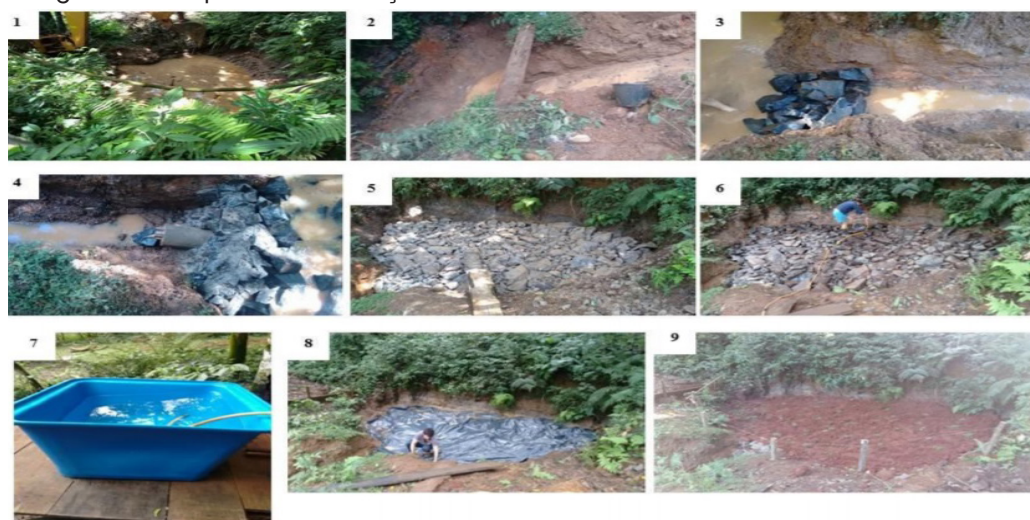
Fotografia 2 –Etapas da construção da fonte Caxambu
