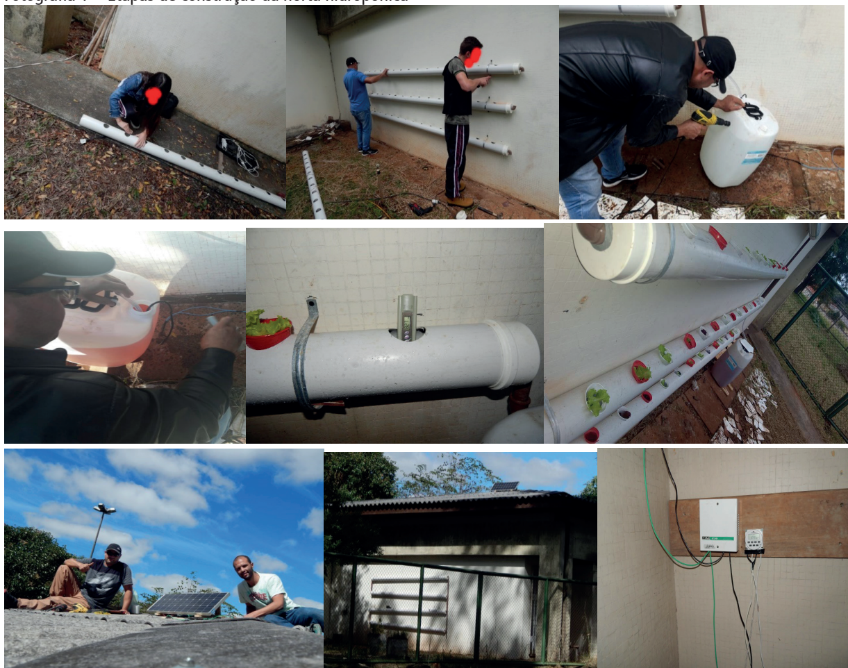
Fotografia 1 – Etapas de construção da horta hidropônica
