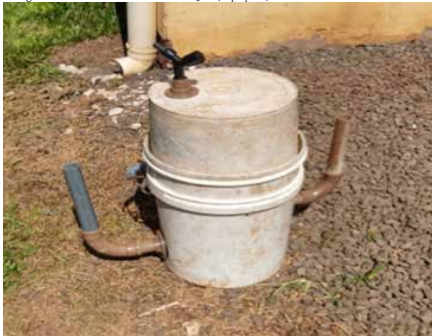
Fotografia 3 – Biorreator em construção (Equipe 1)
