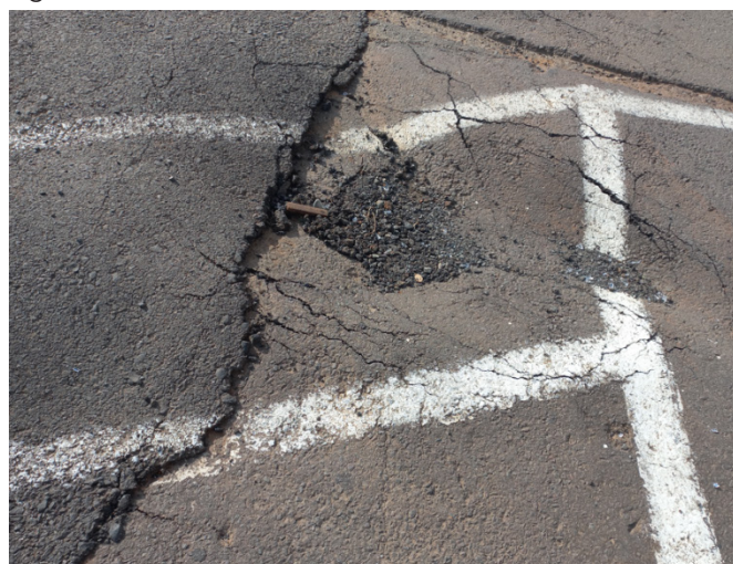
Figura 9: Afundamento
