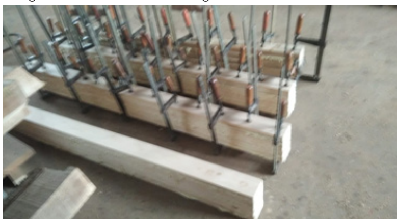
Fotografia 1 – Prensamento das vigas
