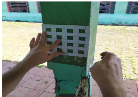
Fotografia 6 – Marcação dos 16 pontos
