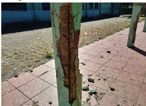
Fotografia 3 – Armadura exposta
