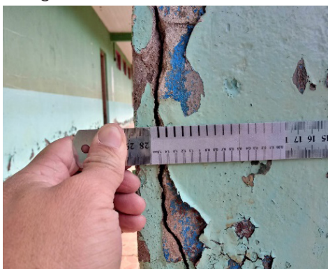
Fotografia 16 – Trinca vertical
