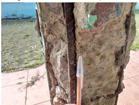
Fotografia 14 – Armadura exposta
