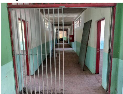
Fotografia 12 – Corredor do bloco 1
