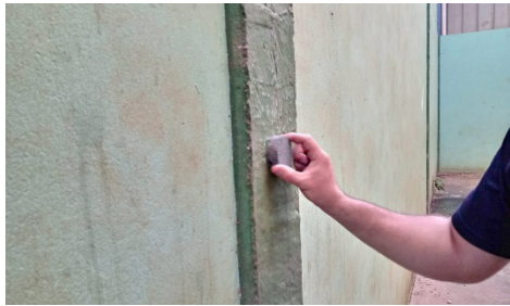
Fotografia 5 – Regularização da superfície
