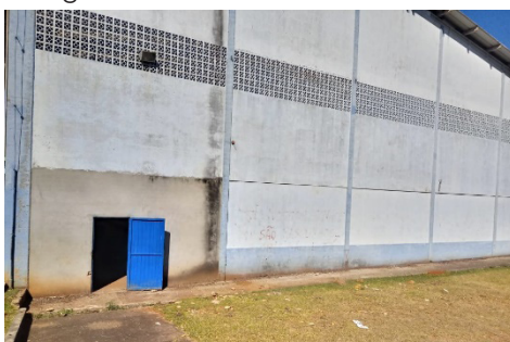
Fotografia 2 – Fachada do Ginásio
