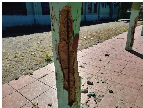
Fotografia 13 – Pilar deteriorado
