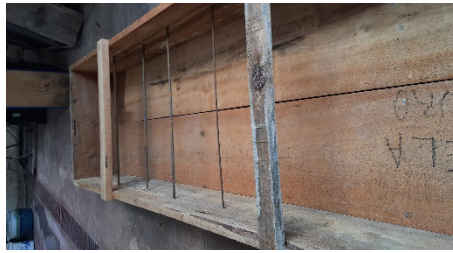
Fotografia 1 - Fôrma da placa
