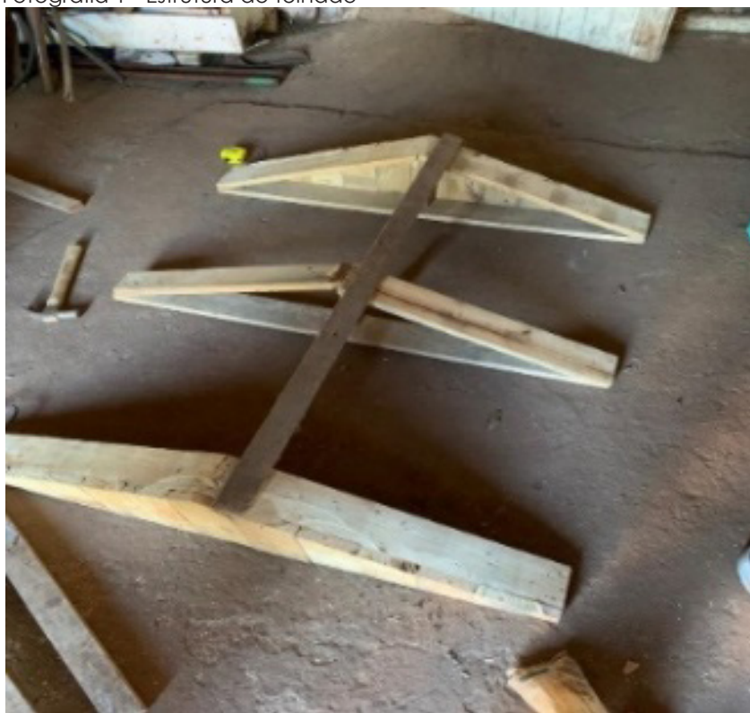
Fotografia 1 - Estrutura do telhado
