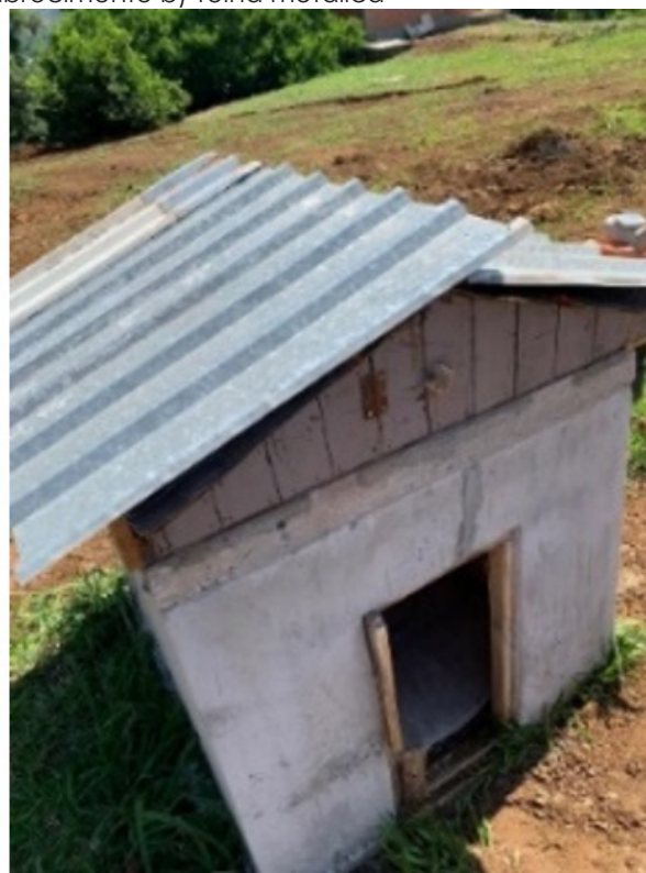
Fotografia 5 - Diferentes tipos de telhas: a) Telha de fibrocimento b) Telha metálica
