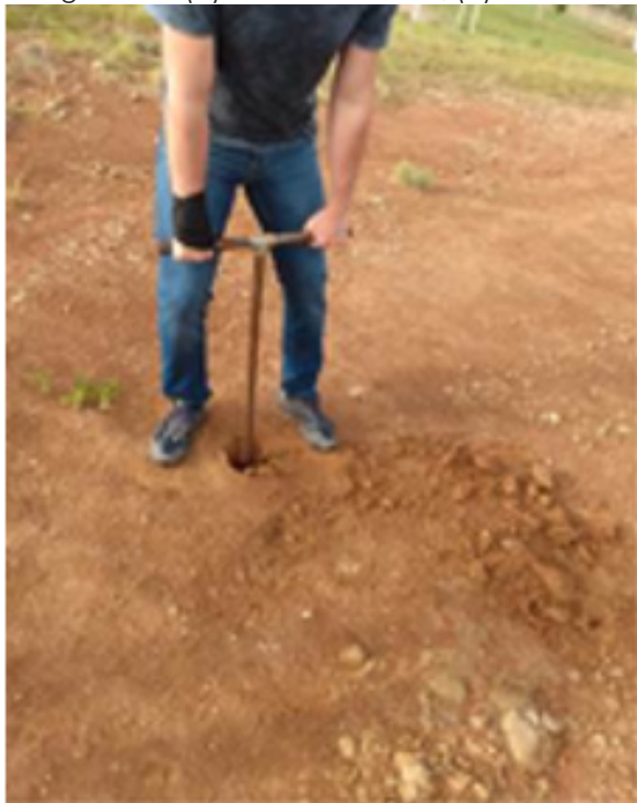
Fotografia 3 – (a) Abertura do furo; (b) Piezômetro instalado
