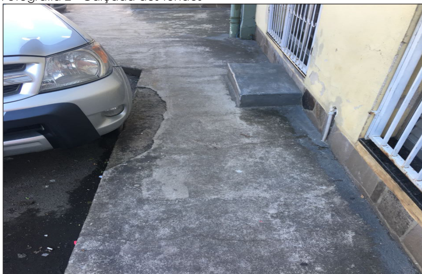
Fotografia 2 - Calçada dos fundos
