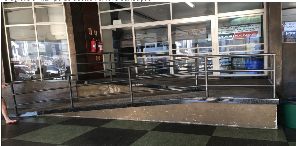
Fotografia 3 - Rampa de acesso frontal a edificação
