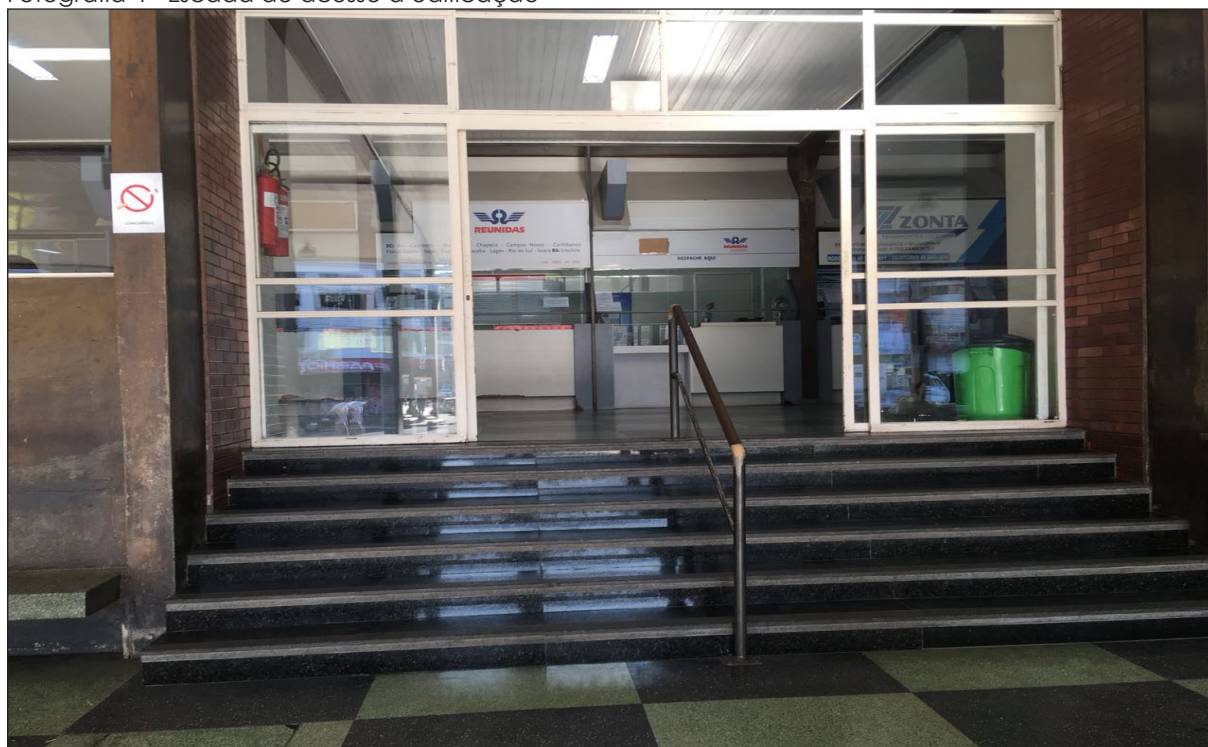
Fotografia 4 - Escada de acesso à edificação
