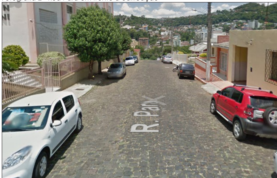
Fotografia 2 - Rua Pará em frente à edificação
