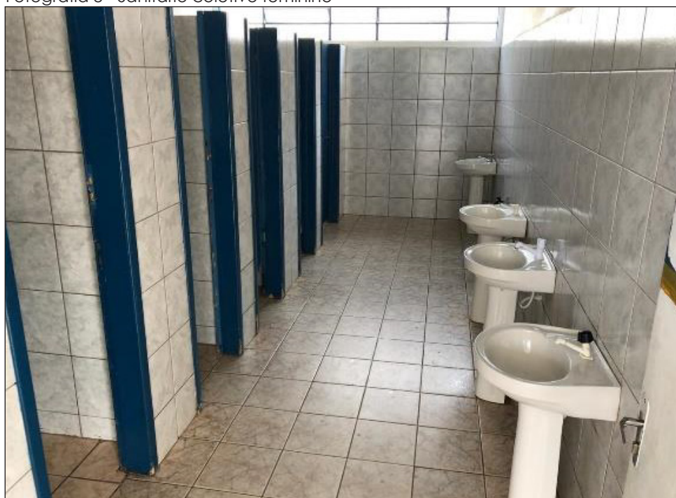
Fotografia 8 - Sanitário coletivo feminino
