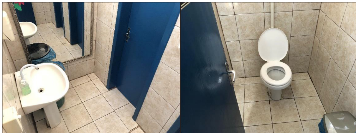
Fotografia 7 - (a) sanitário dos professores – lavatório unissex e (b) sanitário dos professores – bacia sanitária
