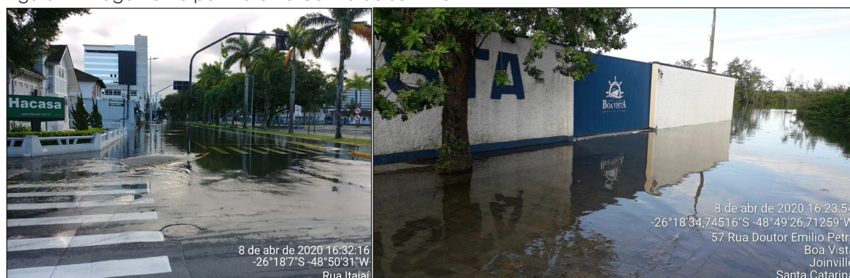
Figura 1 - Alagamento por Maré no Centro de Joinville
