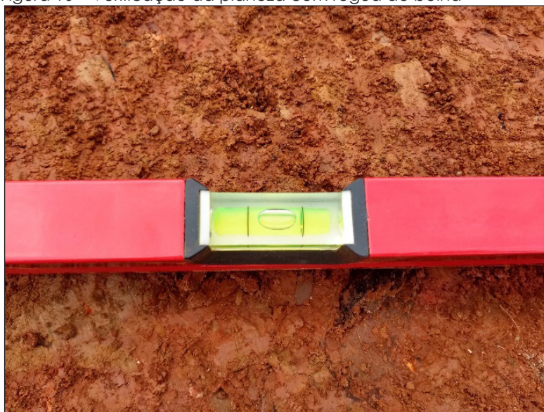
Figura 10 – Verificação da planeza com régua de bolha
