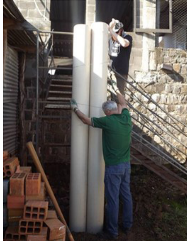
Fotografia 1 – Execução do nivelamento e fixação dos tubos
