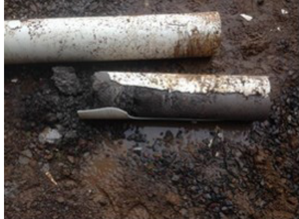
Fotografia 5 – Estado do concreto na ponta da T2
