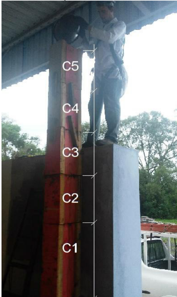
Fotografia 2 – Posicionamento das formas para lançamento do concreto
