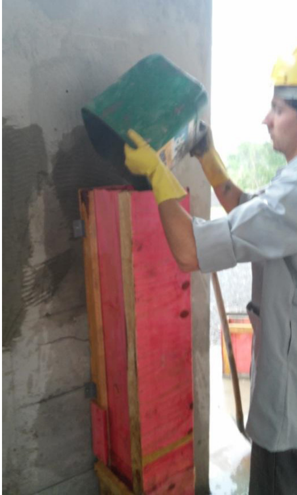
Fotografia 3 – Lançamento de concreto a 1,5 m
