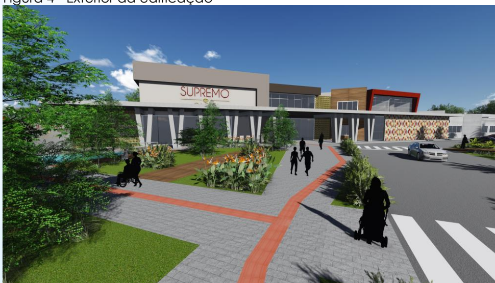
Figura 4 - Exterior da edificação
