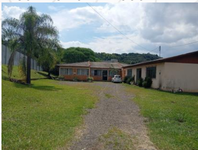
Area Externa - Entrada
