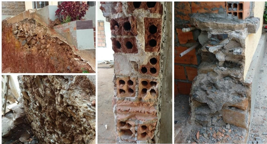
Figura 2 – Base ciclópica e Paredes da obra.
