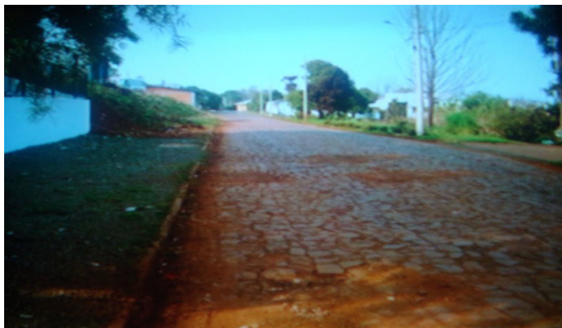
Fotografia 3 – Via de acesso à obra: pavimentação poliédrica
