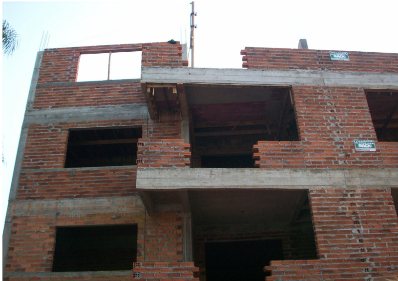
Fotografia 1 – Edificação em estudo: vista da elevação frontal
