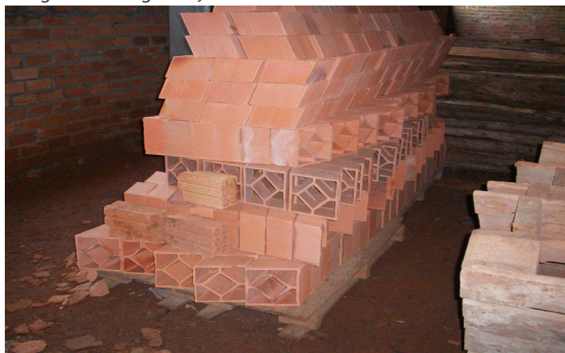
Fotografia 7 – Organização do canteiro
