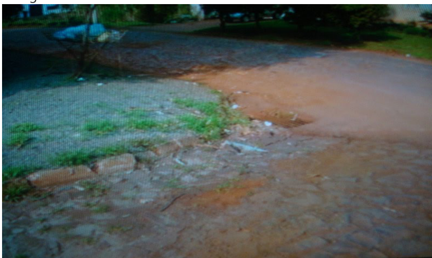
Fotografia 4 – Via de acesso a obra: bueiro
