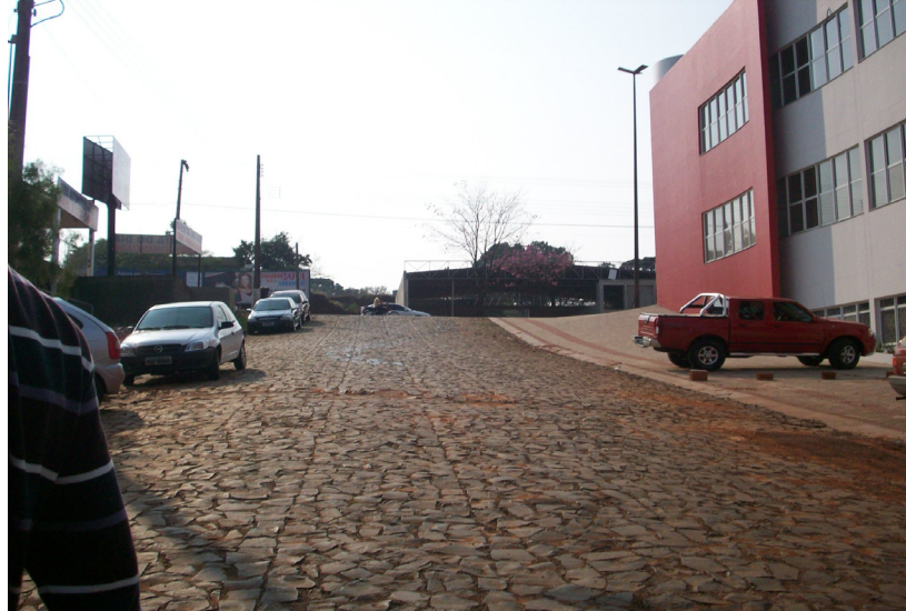
Fotografia 2 – Via de acesso a obra
