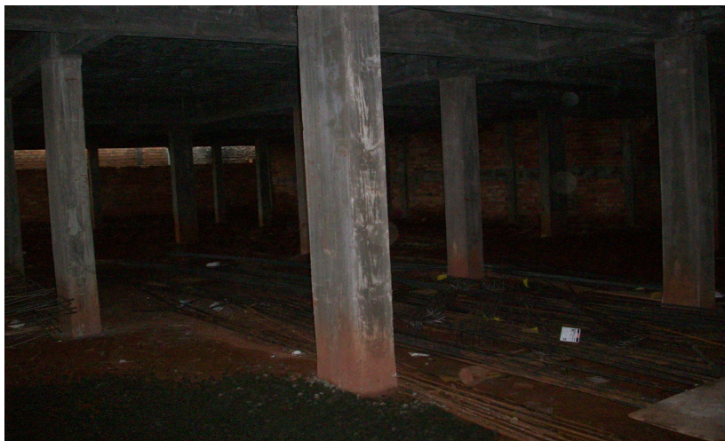
Fotografia 6 – Organização do canteiro
