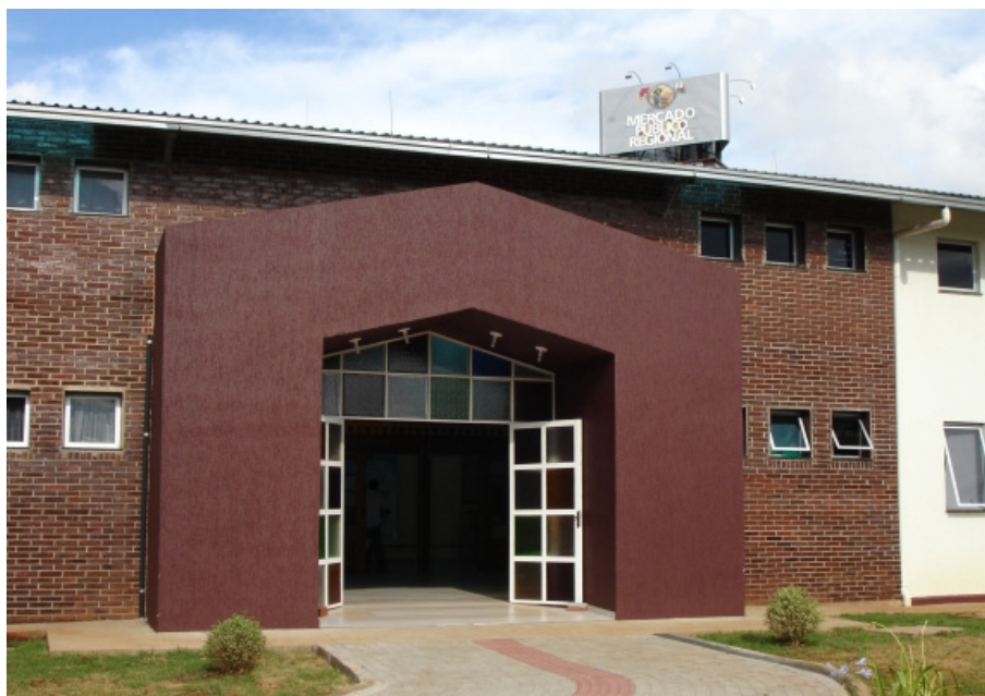
Fotografia 3 – Mercado Público de Chapecó
