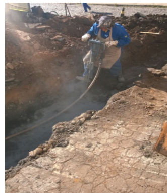
(b) Perfuração com rompedor pneumático
