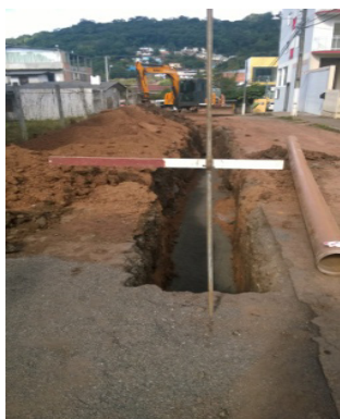
(a) Vala em via urbana locada no eixo pista
