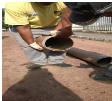
(b) Preparação tubo de PVC 200 mm
