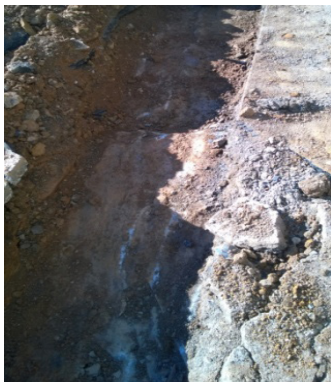
(a) Vala para rede de esgoto
