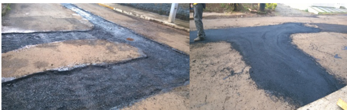
Fotografia 5 – Reconstituição da via pública após assentamento da rede coletora de esgotos
