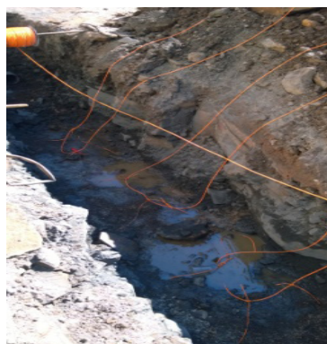
(b) Ligação concluída do cordel detonante
