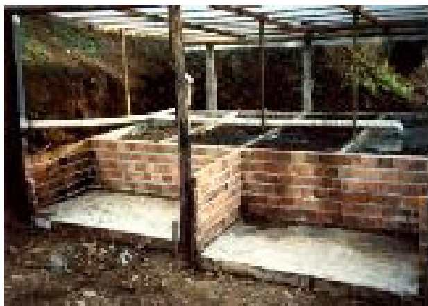
Fotografia 2 – Localização das câmaras incorporação e compostagem de dejetos
