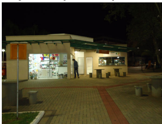
Fotografia 5 – Praça de alimentação
