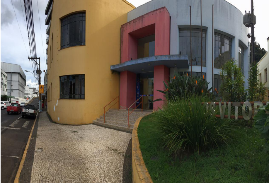
Fotografia 1 – Fachada frontal do CEVI
